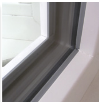
TPS-Abstandhalter: klare, optische Vorteile auch bei 3fach Isolierglas
