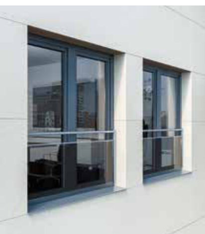
Als kombinierte Variante mit Stange und Glas bilden Absturzsicherungen ein Highlight in der Fassadenansicht
