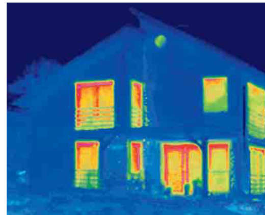
Infrarotaufnahmen, Thermografien, zeigen deutlich, wo ein Haus unkontrolliert Energie verliert. Rot bedeutet Wärme- und damit hohen Energieverlust.
